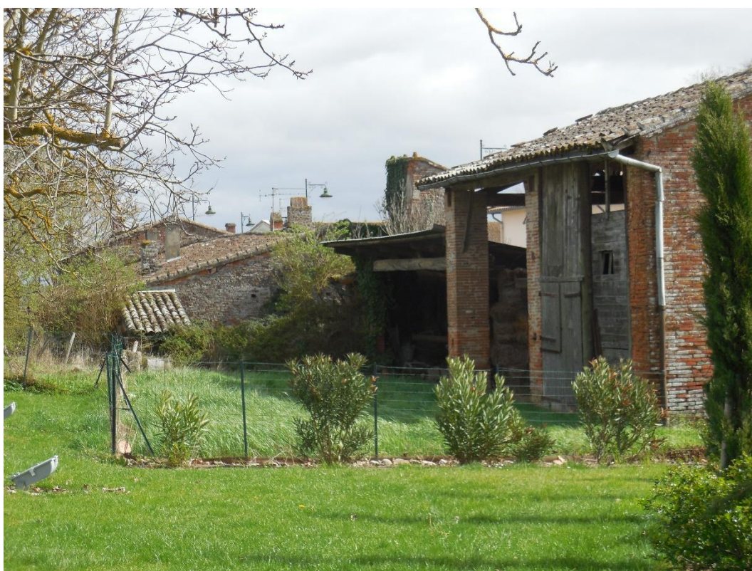
Photo : Bâti ancien avenue de la Viste zone UA
