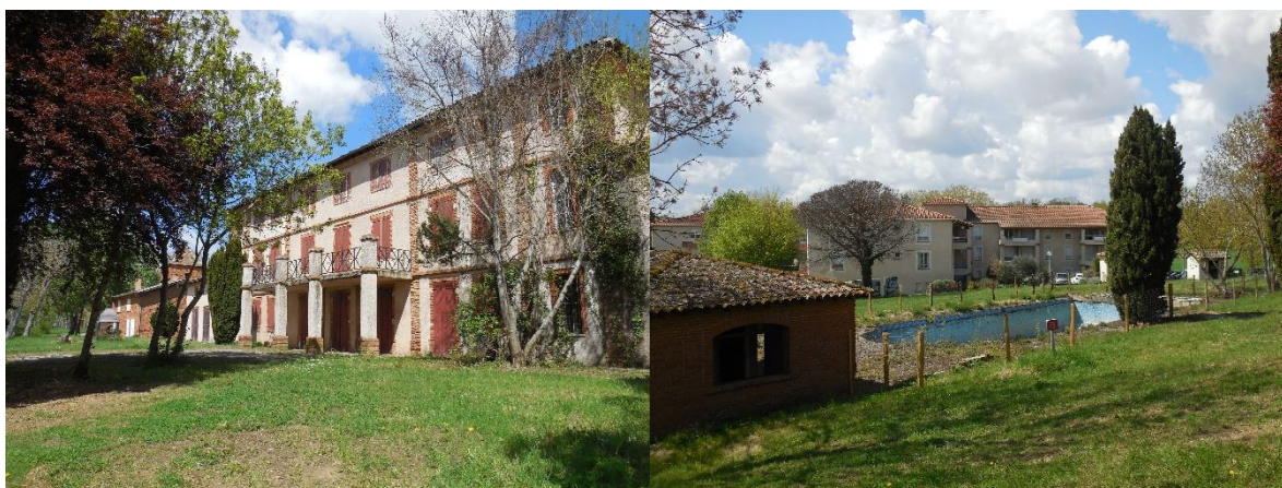
Le bâtiment à démolir et son parc.
